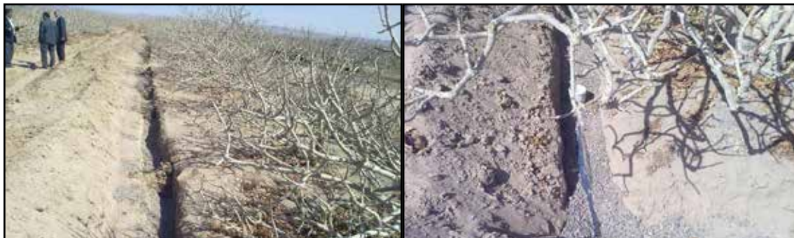
شکل ۱- وضعیت نصب و استقرار لوله‌های زیرسطحی پی‌وی‌سی در کنار درختان پسته
